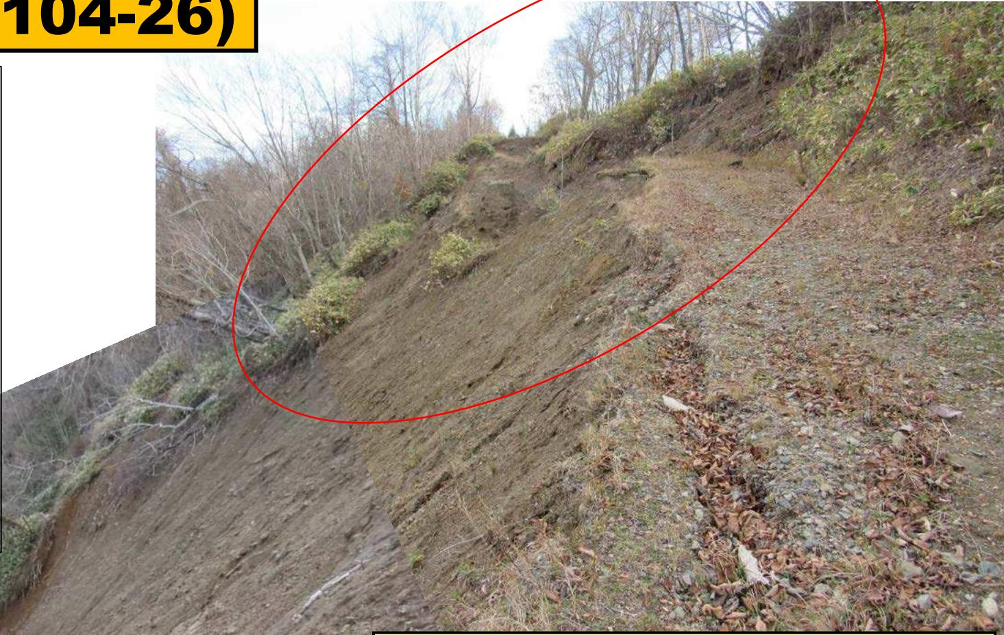
図2 Sr-RC2(林道切土・路盤の崩壊)
